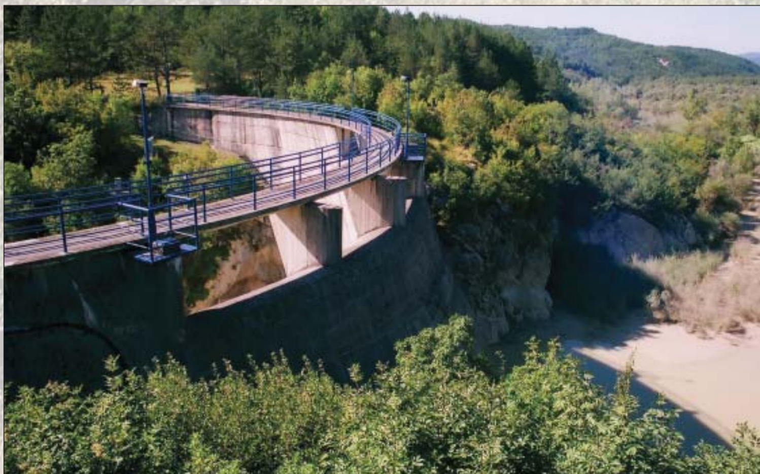
La diga che regola il corso della Boljunčica all'inizio della Valdarsa
